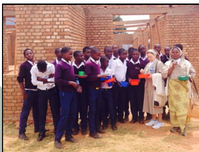
Las Religiosas Nieves y Domitila comiendo con los alumnos de Lugarawa delante de la construcción del nuevo comedor.
